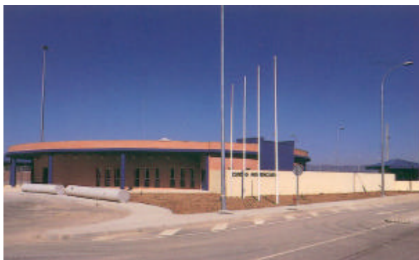
Centro Penitenciario de Córdoba
